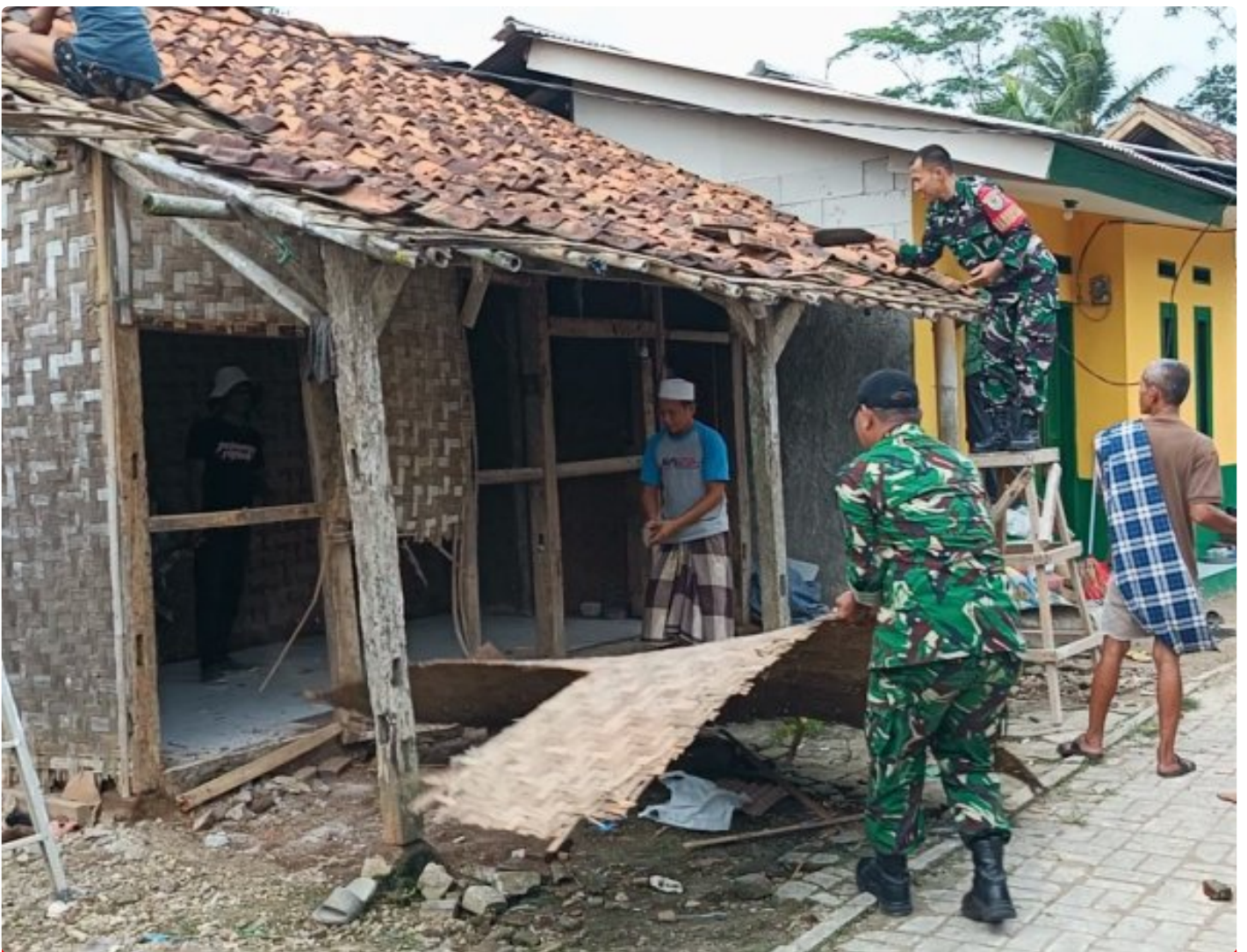
Pembongkaran Rumah Bapak Narmin
