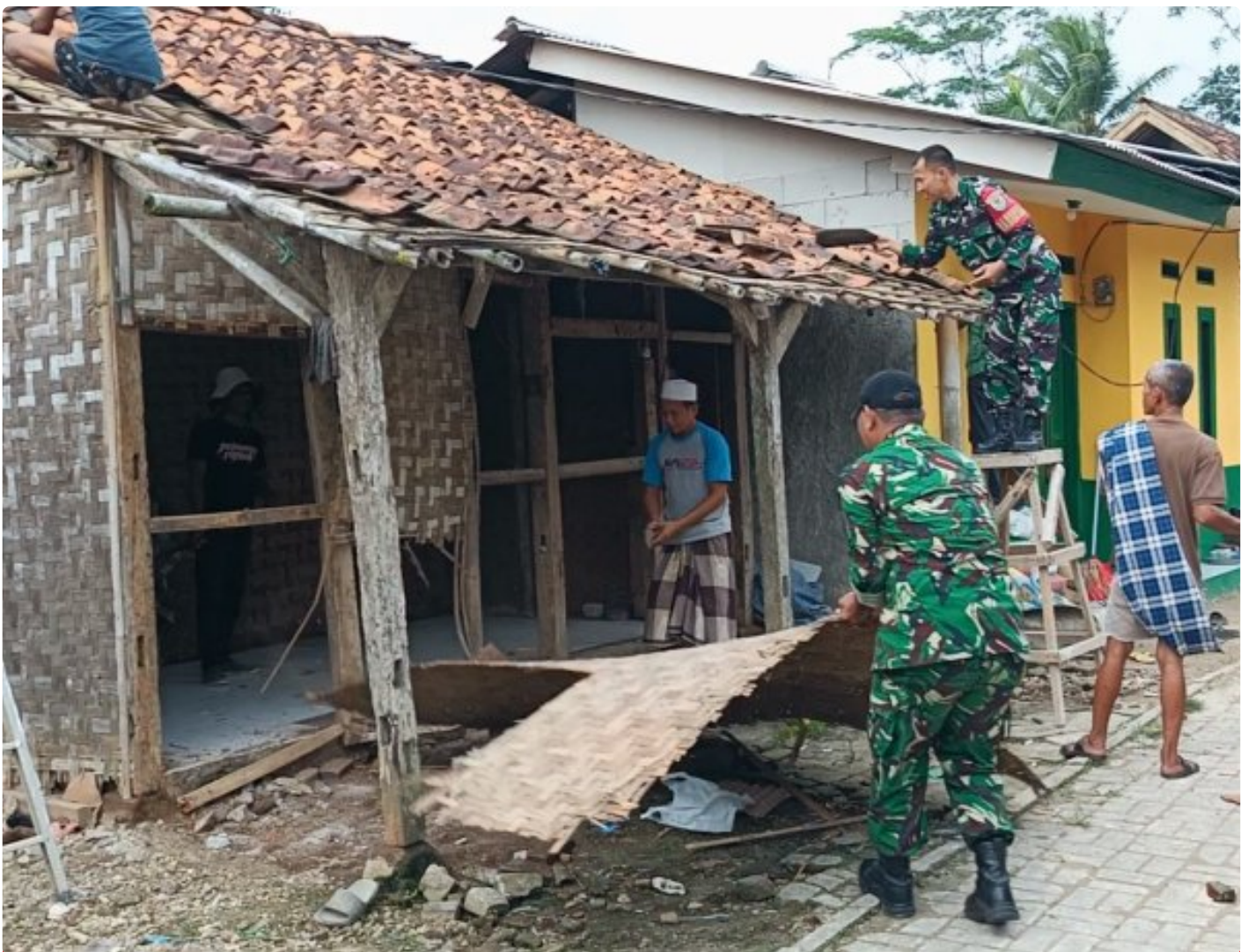
Pembongkaran Rumah Bapak Narmin
